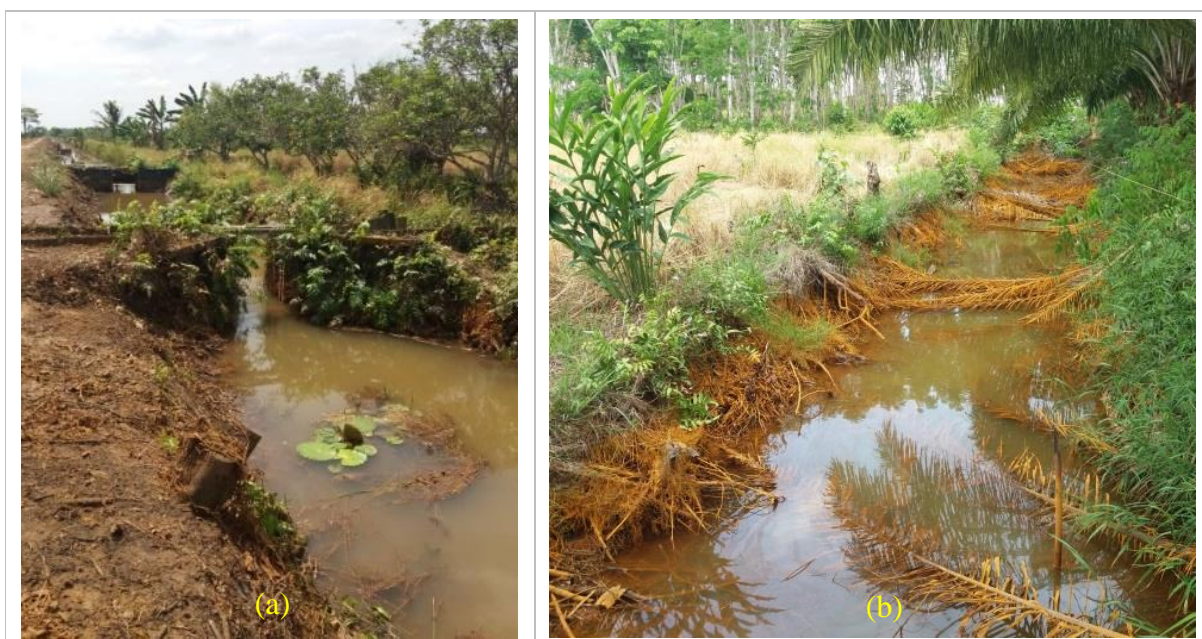
Gambar 5 Kondisi aliran di saluran tersier pada saat pasang (a) dan pirit yang ada di pangkal saluran (warna coklat kekuningan) (b)
