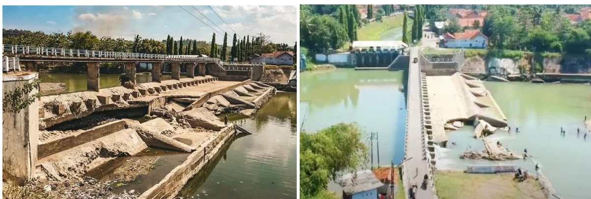
Gambar 4 Tampak samping Bendung Cikeusik (sumber : BBWS Cimanuk Cisanggarung, 2020)
