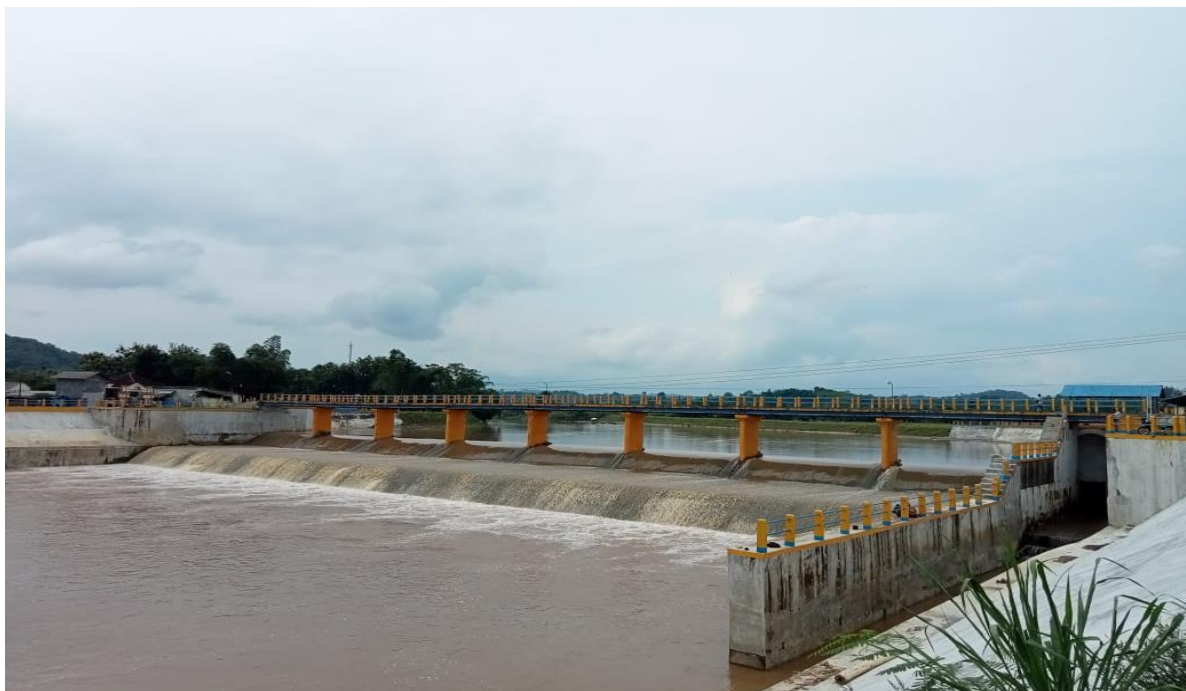
Gambar 22 Kondisi Bendung Cikeusik setelah dilakukan perbaikan dengan desain alternatif 2
