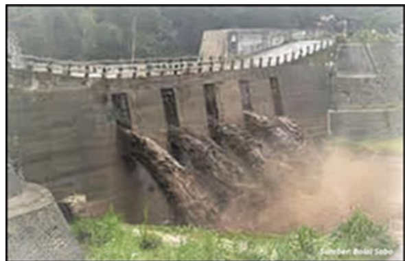
Gambar 9 Sabodam tipe gorong-gorong digunakan sebagai jembatan dan penahan material batuan besar
