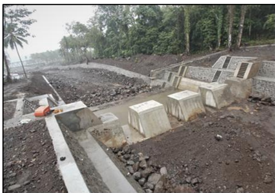
Gambar 8 Salah satu kanalisasi di dekat muara sungai di daerah Gunungapi Gamalama
