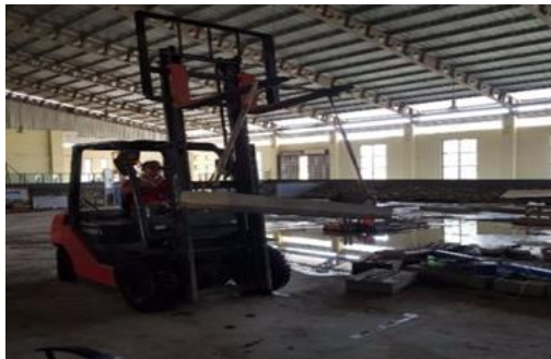
Gambar 12 Proses pengangkatan modul dengan forklift
