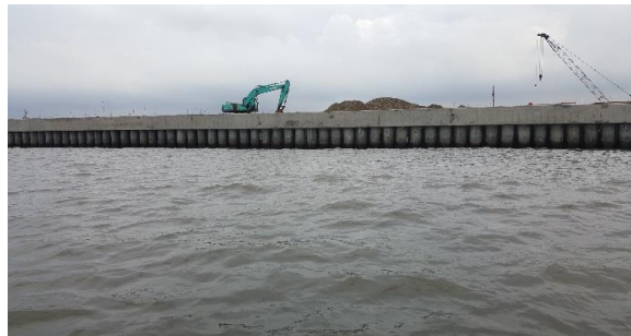
Gambar 2 Bagian tanggul luar dengan menggunakan spun pile pada tanggul tahap A NCICD
