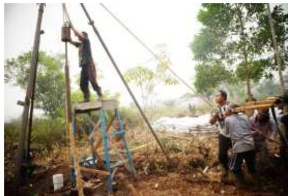
Gambar 32 Pemancangan cerucuk diselimuti pasir
