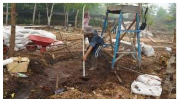
Gambar 19 Pemasangan Setletment plat Model fisik tipe A
