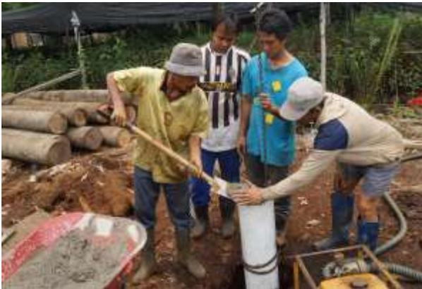
**Gambar 33** Pembuatan alternatif fondasi tiang pasir diselimuti paralon
