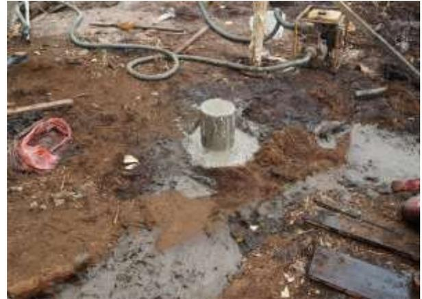
**Gambar 34** Alternatif fondasi tiang cor di tempat
