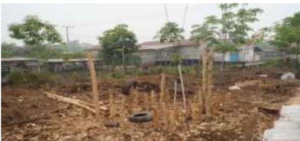
**Gambar 22** Pemasangan pondasi cerucuk model fisik B
