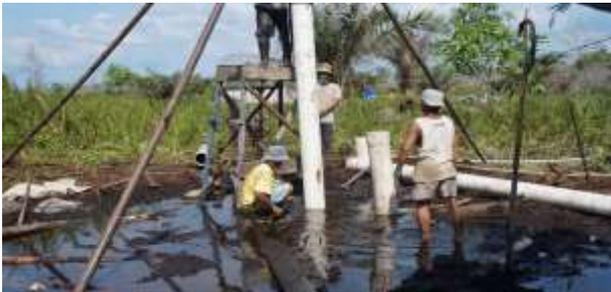
**Gambar 26** Pemasangan fondasi alternatif (pipa cor) Model fisik tipe C
