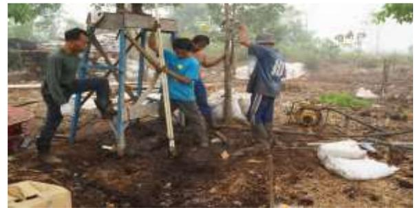
Gambar 18 Pemasangan instrument piezometer di model fisik A
