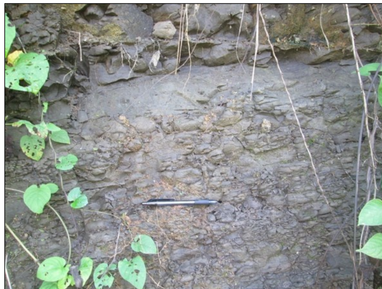
Gambar 4 Kondisi lempung, di lokasi sebelah selatan asrama putri Hambalang.
