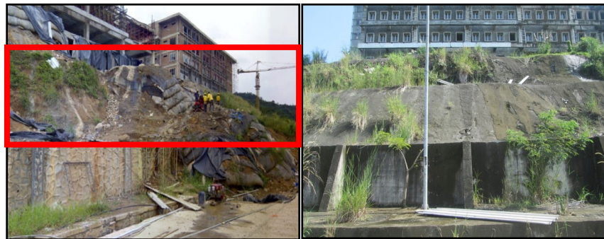
Gambar 15 Kiri kejadian longsor 2012, kanan kondisi sekarang
