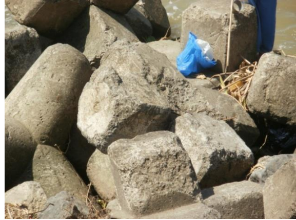
Gambar 2 Kondisi BBT di hilir Bendung Karet Jatimlerek
