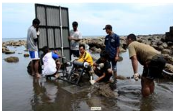
Gambar 10. Pemasangan pompa flap di lapangan
