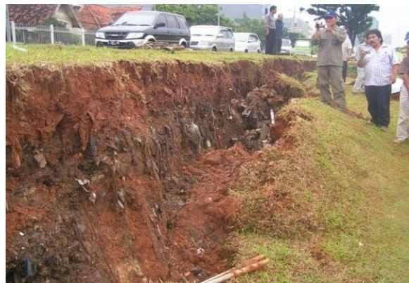
**Gambar 4** Tanah timbunan yang mengalami longsor, terlihat sampah plastik
