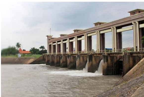
Gambar 3 Pintu-pintu Bendung Pasarbaru dilihat dari arah hilir, lebar masing-masing pintu adalah 10 meter
