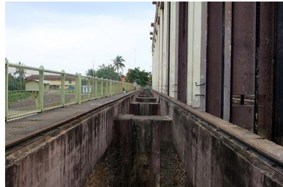
Gambar 4 Struktur Bendung Pasarbaru dari arah hilir, dijalan inspeksi inilah pengukuran georadar dilakukan
