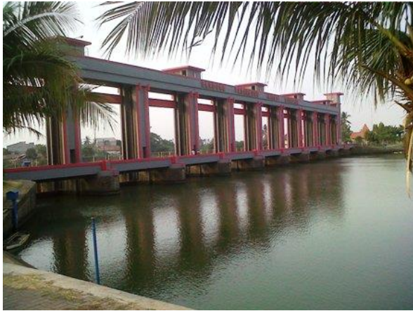
Gambar 2 Bendung Pasarbaru Irigasi Cisdane
