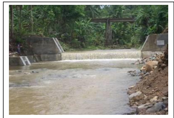
Gambar 5b Prototipe sabodam K. Lumajang di Linggasari DAS Waduk Mrica. (Dok. Soewarno, 2010)
