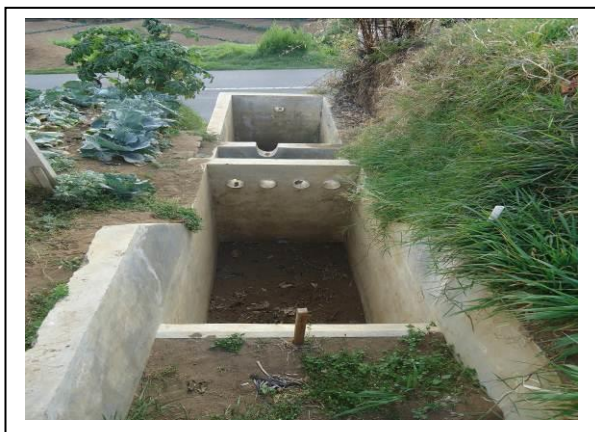
Gambar 9a Sabodam mikro tipe konstruksi beton di desa Bakal Dieng (Dok. Soewarno, 2010)
