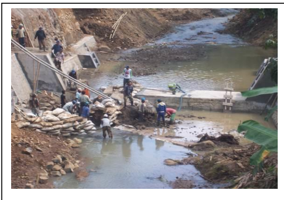
Gambar 5a Pembangunan prototipe sabodam K. Lumajang di Linggasari DAS Waduk Mrica
