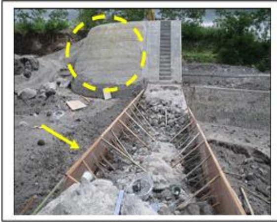
Gambar 12 Revetment dilakukan di bagian hulu sayap, dan pelebaran peluap
