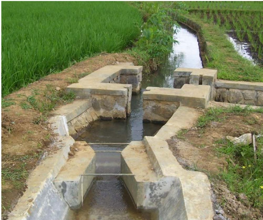
**Gambar 4** Alat ukur CTF pada saluran kuarter
