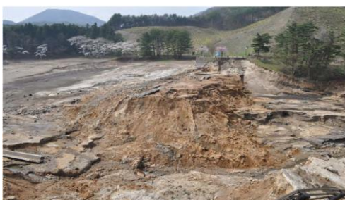
Gambar 1 Keruntuhan Bendungan Fujinuma Akibat Gempa (Pradel, 2013)
